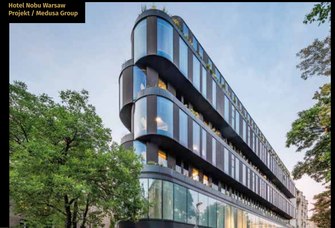
Zastosowane systemy Aluprof: fasada słupowo-ryglowa MB-SR50N EFEKT, fasada słupowo-ryglowa MB-SR50N EI EFEKT, okna odchylno-wysuwne MB-SR50N OW, okna i drzwi z przegrodą termiczną MB-86 SI oraz MB-86 ST, drzwi przesuwne z ukrytą ramą MB-Skyline, przegroda przeciwpożarowa z drzwiami MB-78 EI
