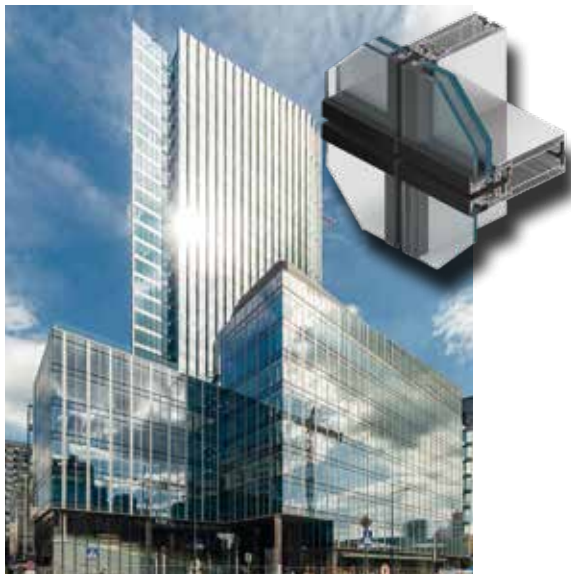
MENNICA LEGACY TOWER Località: Warszawa Progetto: Goettsch Partners
