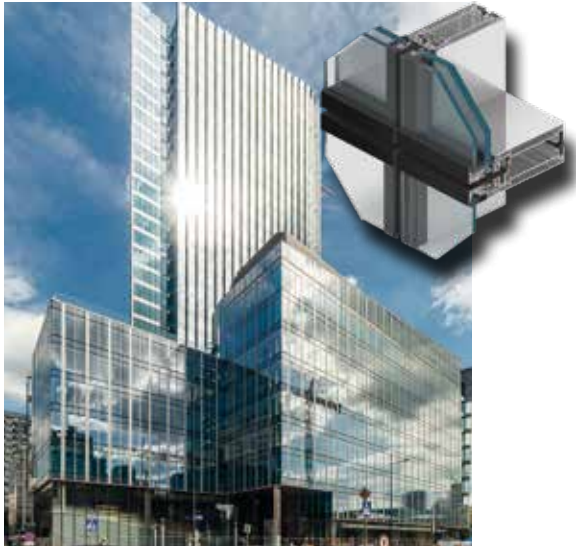
MENNICA LEGACY TOWER Localisation: Varsovie / Pologne Projet: Goettsch Partners
