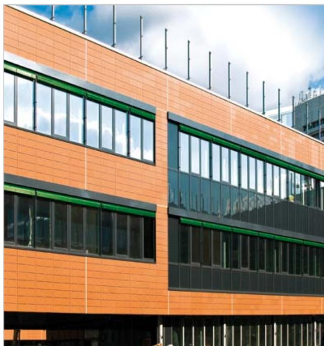
Система сегментной стены MB-SE75 предназначена для реализации индивидуальных объектных решений, основным требованием к которым является быстрый монтаж фасада, а также отсутствие строительных лесов во время строительства. Характерными особенностями этой системы являются современный внешний вид фасада, очень хорошие термоизоляционные параметры, а также технология производства, гарантирующая получения продукции высокого уровня.
