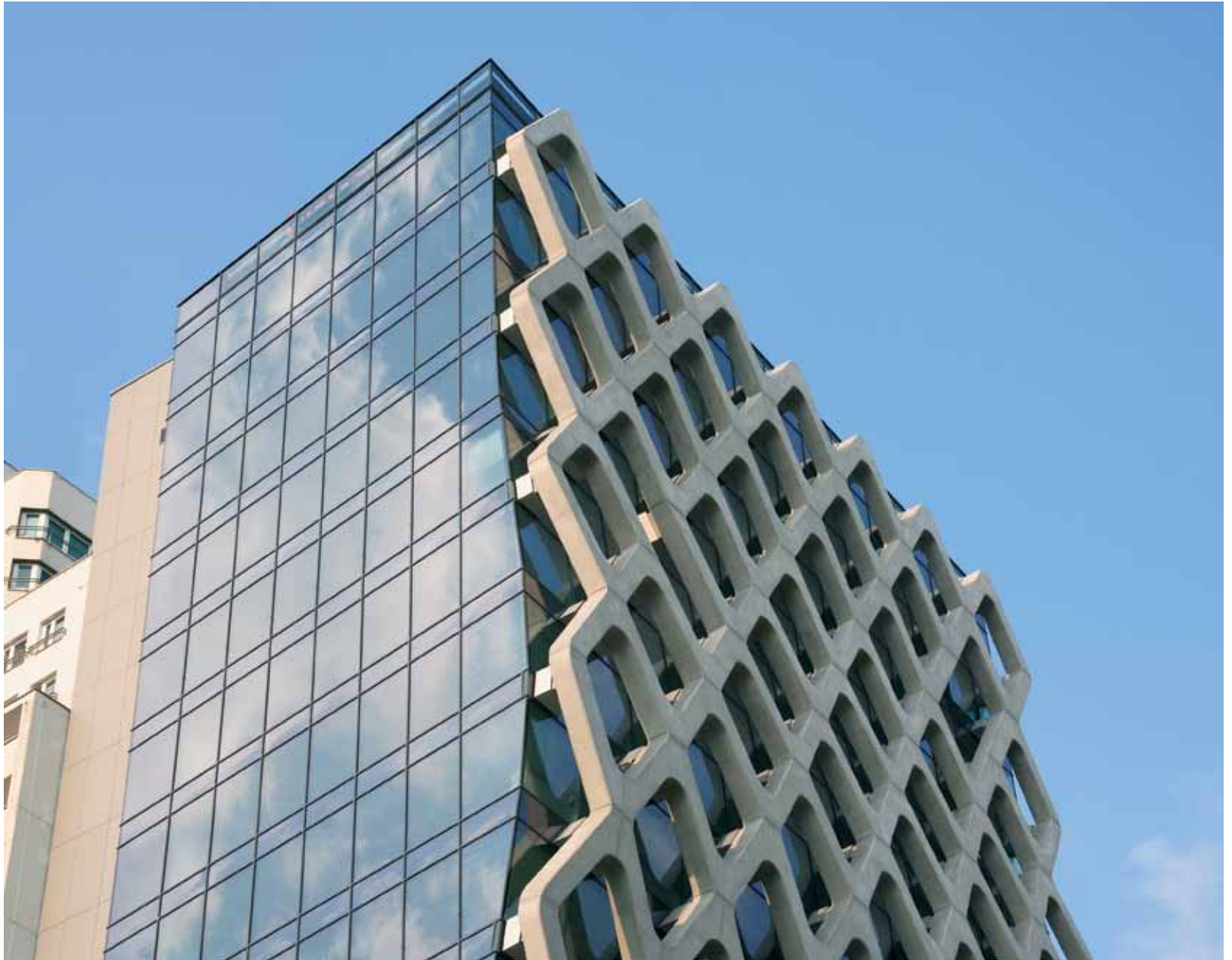
Prosta Tower, Warszawa Projekt: APA Kuryłowicz & Associates
