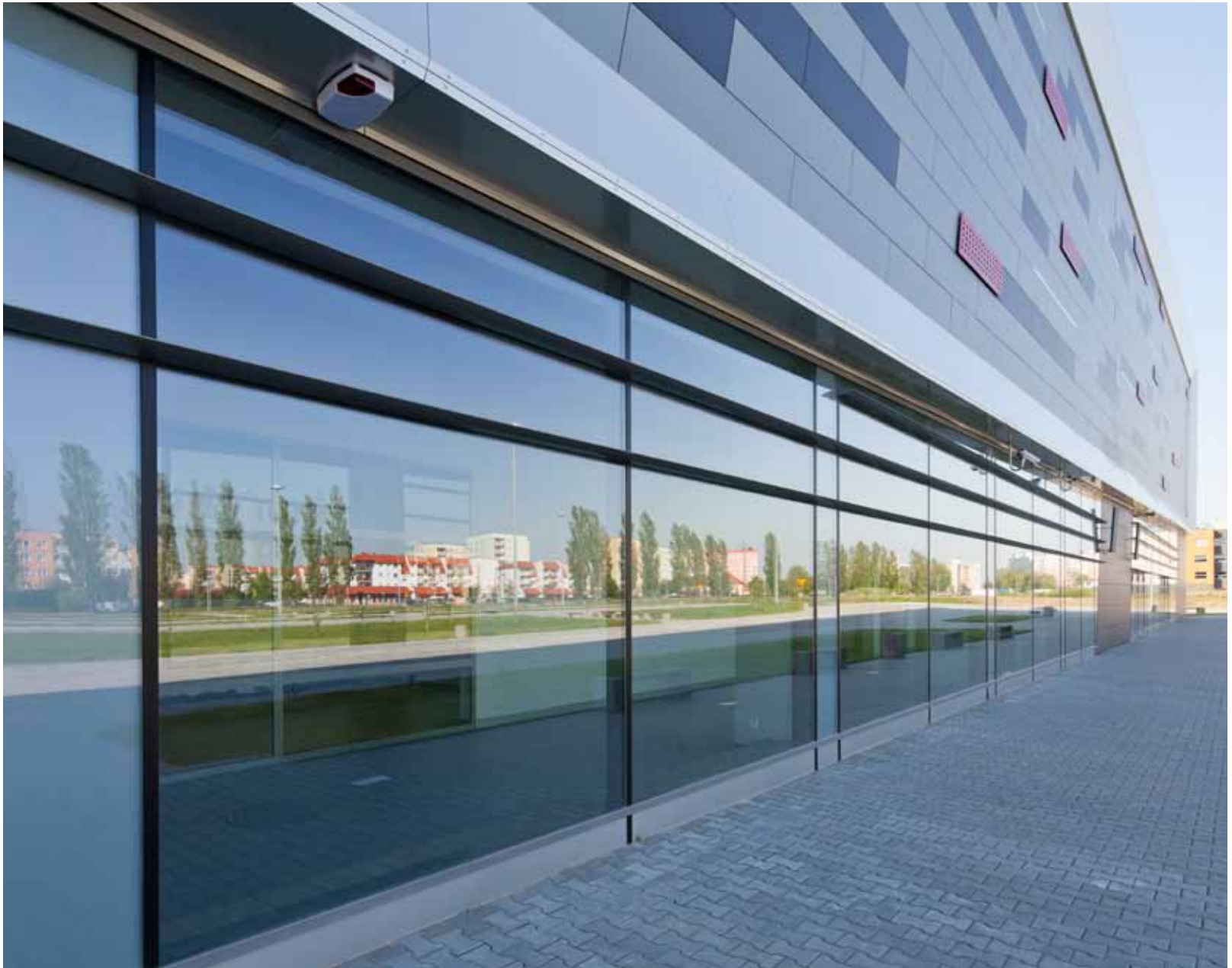
Hala Sportowo-Widowiskowa, Koszalin Projekt: Archimedia
